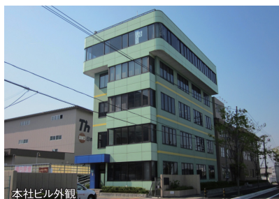
本社ビル外観
