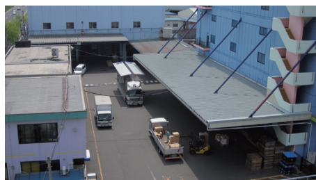
■配送拠点となる構内風景
