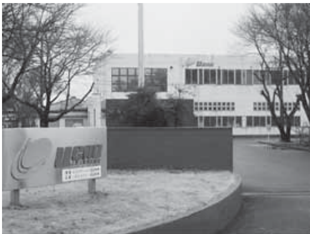
写真1 栃木工場外観
