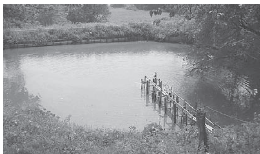
写真2 溜池を活用した工場入口の浄化槽
