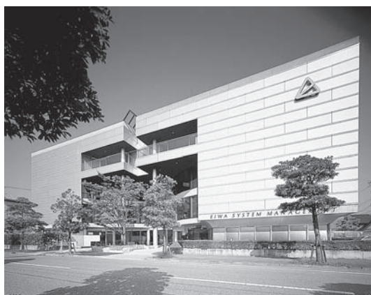
資料1 本 社 ビル
